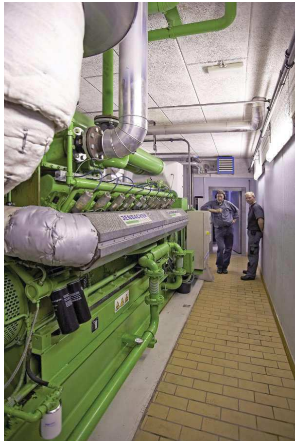
De to gasmotorer på Harboøre Varmeværk yder henholdsvis 650 og 740 kW og producerer el og varme af forgasningsgassen med en elvirkningsgrad på 28 pct. (Foto: Torben Skøtt og Kim Jensen)
